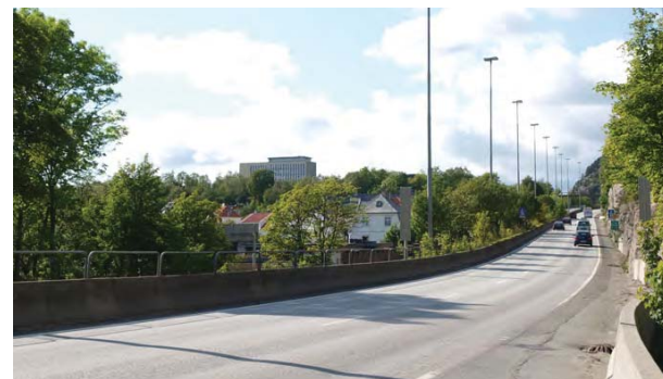
situasjon 3 sett fra vei mot nord - eksisterende situasjon
